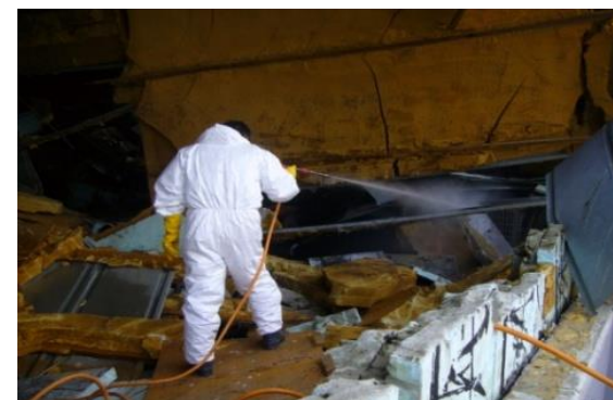
宮城県気仙沼市 超低温冷蔵庫 腐敗魚の除菌と消臭作業
